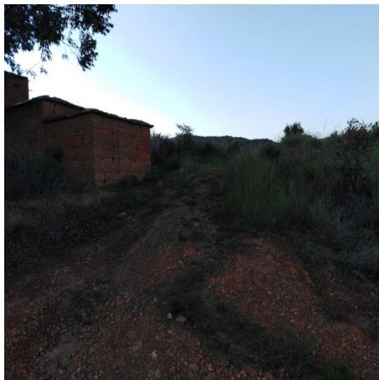
图 1 用地中部南面入口处废弃土房
